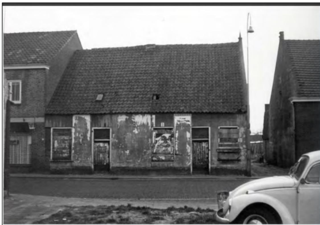
Figuur 11. Het pand Haageijk 22-24 vóór de sloop in 1977 (bron: Heemkundekring De Kommanderij Gemert).
