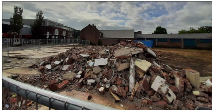
Figuur: resultaat van sloopwerkzaamheden (04-08-2022). De gebouwen geschikt voor steenmarter zijn gesloopt en het terrein is niet meer geschikt voor steenmarter en teunisbloempijlstaart.
