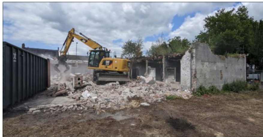
Figuur: sloopwerkzaamheden waargenomen op 27-07-2022 aan de Komweg 2 en Haageijk 26.
