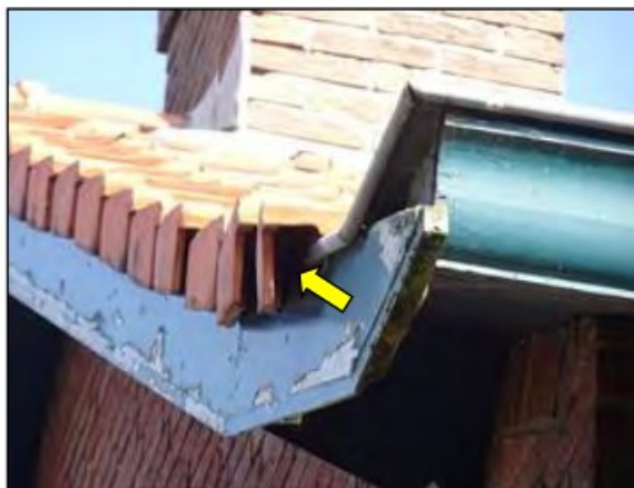
Figuur 16. Ruimte onder de overhangende dakpannen.
