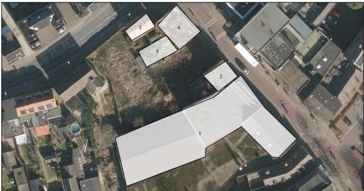
Figuur 3. De verschillende onderdelen op de onderzoekslocatie; 1 = winkelpand met loods; 2 en 3 = leegstaande woningen; 4 = afgebrande woning en 5 = schuur.
