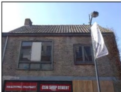
Figuur 10. De woning aan de Haageijk (2)
