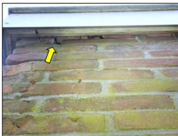
Figuur 22. Ruimte achter de betimmering.
