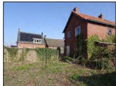
Figuur 9. De woning aan de Komweg (3), kijkrichting noord.
