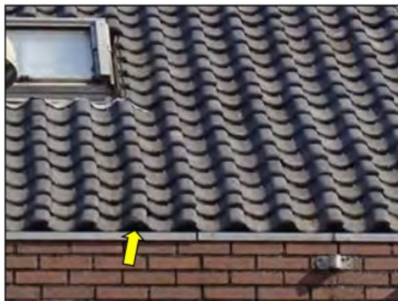
Figuur 15. Ruimte onder de dakpannen.
