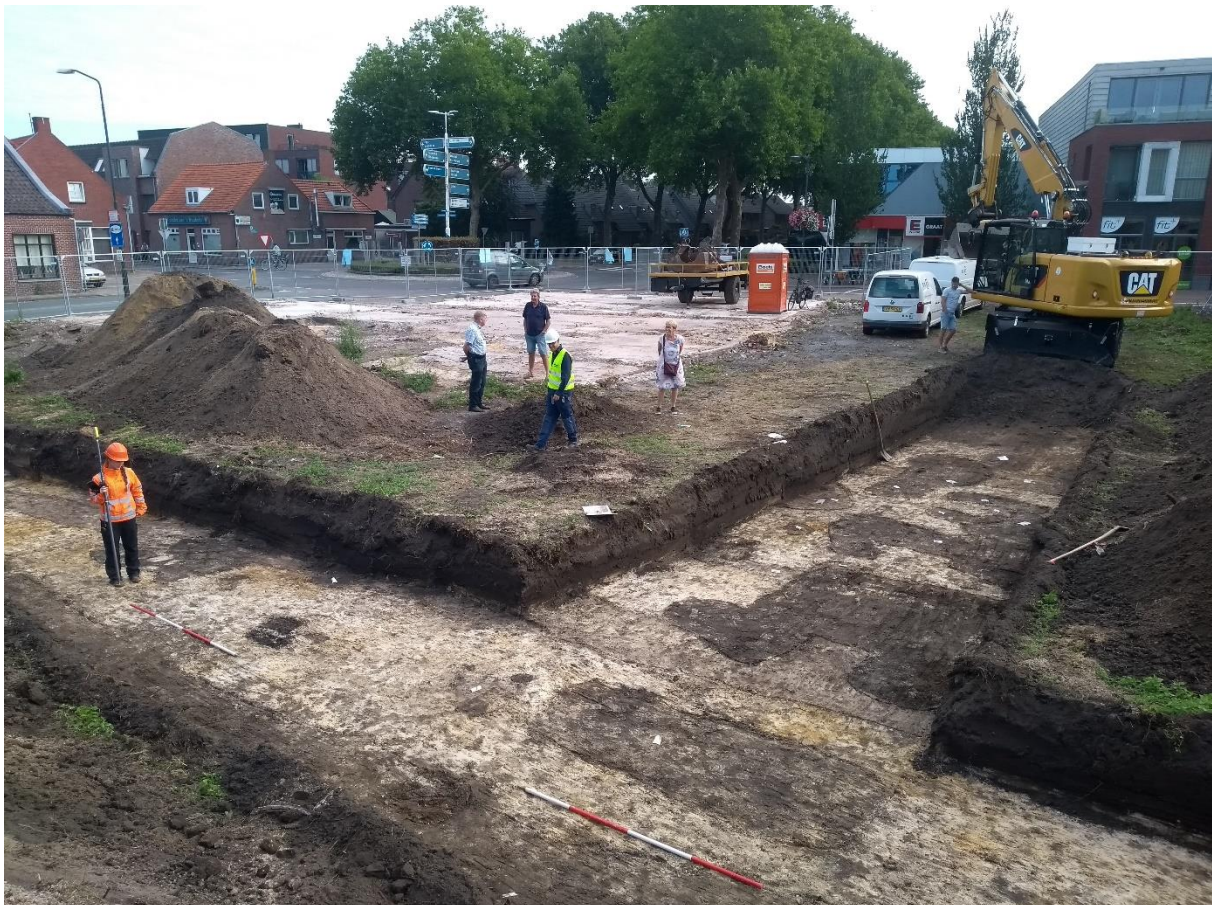
Figuur 3. Foto van de aanleg van de proefsleuven (WP1 en 2) met de vloerniveaus van Haageijk 26 op de achtergrond.
