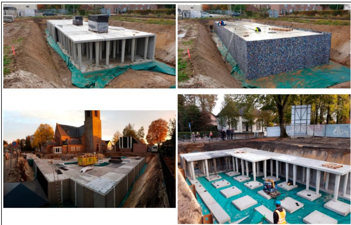
Figuur 5: Impressie Watertable-systeem (bron: www.trewwatin.nl )
