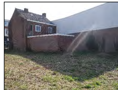
Figuur 11. De woning aan de Haageijk (2) en de loods behorende bij het naastgelegen winkelpand (1), kijkrichting oost.
