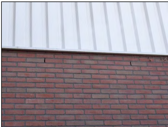
Figuur 21. Open stootvoegen.
