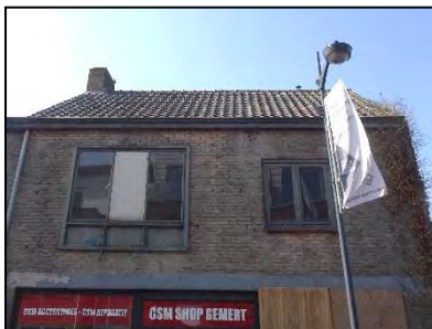
Figuur 10. De woning aan de Haageijk (2)
