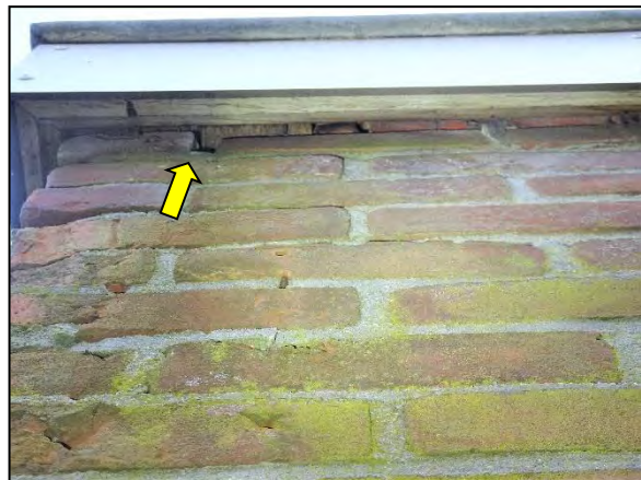
Figuur 22. Ruimte achter de betimmering.
