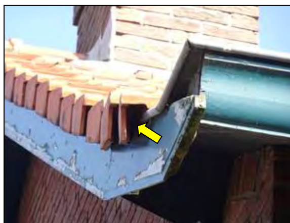
Figuur 16. Ruimte onder de overhangende dakpannen.
