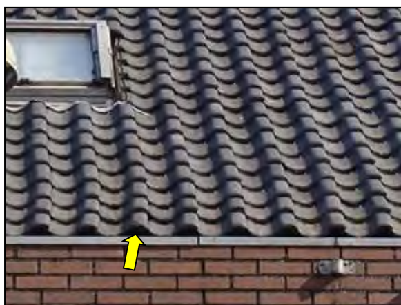
Figuur 15. Ruimte onder de dakpannen.
