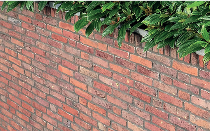
Bakstenen trappen en muren sluiten aan bij gevel
