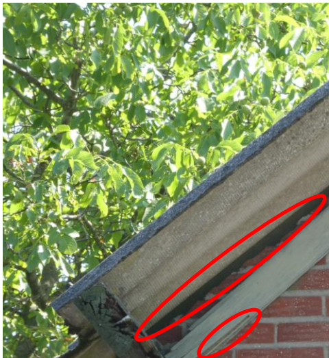
Afbeelding 14. Eén van de locaties met gaten, kieren en/of spleten (rode markering) in het gebouw.
