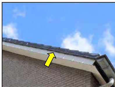
Figuur 17. Toegang voor vleermuizen in de vorm van ruimtes onder overhangende dakpannen bij het woonhuis.
