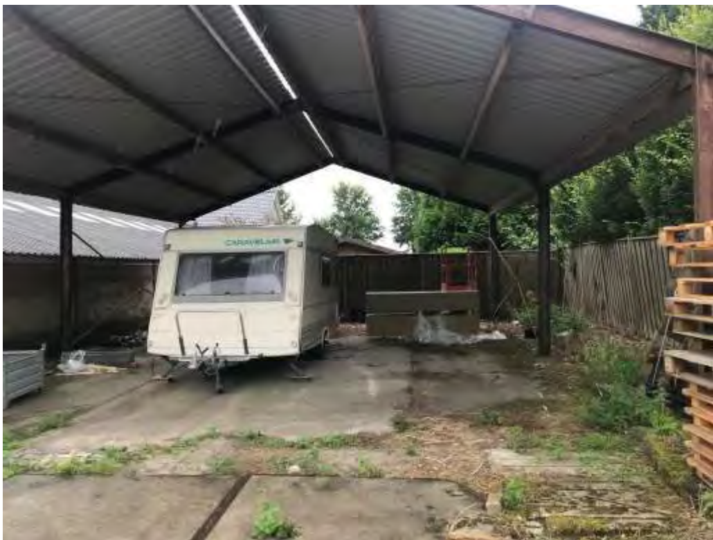
Foto 4: overdekte schuur met betonverharding
