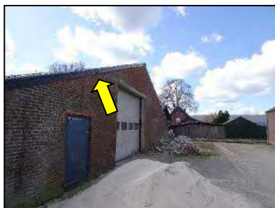
Figuur 18. Toegang voor vleermuizen naar ruimtes tussen in de spouwmuur via de daklijst aan de noordgevel van de voormalige koeienstal.
