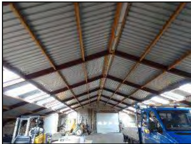
Figuur 9. Binnenzijde voormalige koeienstal.
