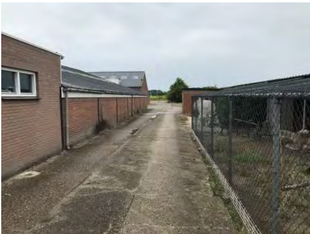
Foto 2: Erfpad (beton) tussen schuur en vogelren
