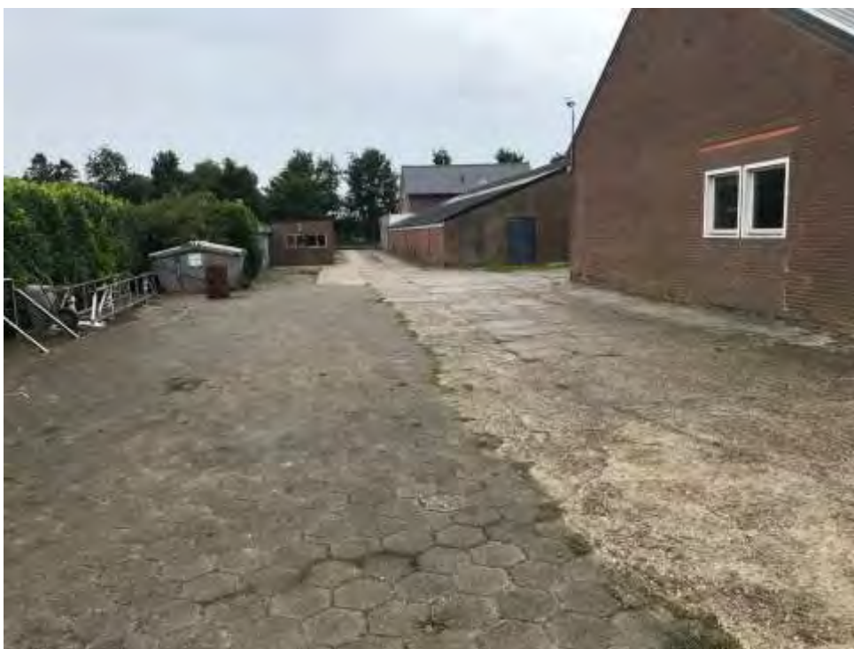
Foto 9: Achterzijde terrein voorzien van betonverharding en betontegels
