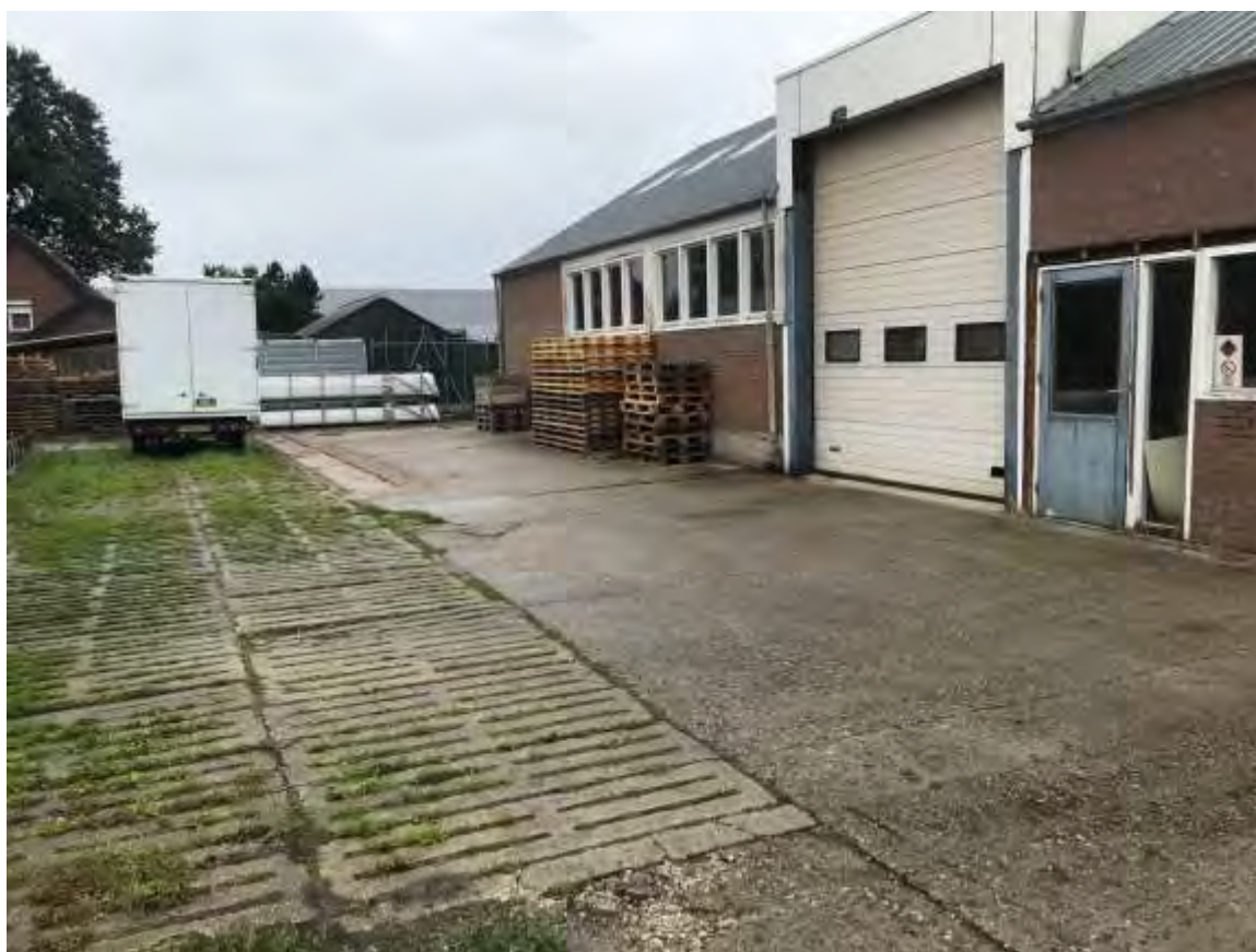
Afbeelding 2: Foto loods annex werkplaats met ligging betonverharding
