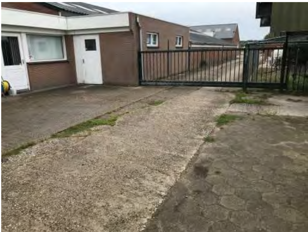
Foto 1: Toegangspoort met betonverharding en beton tegels
