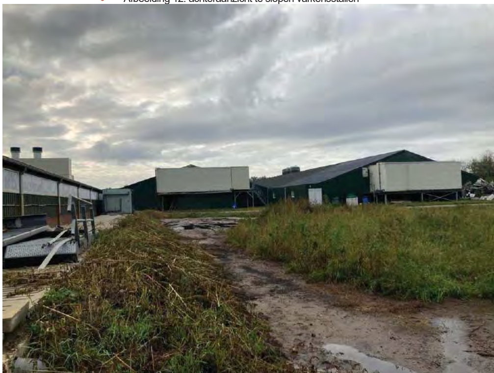
• Afbeelding 12: achteraanzicht te slopen varkensstallen
