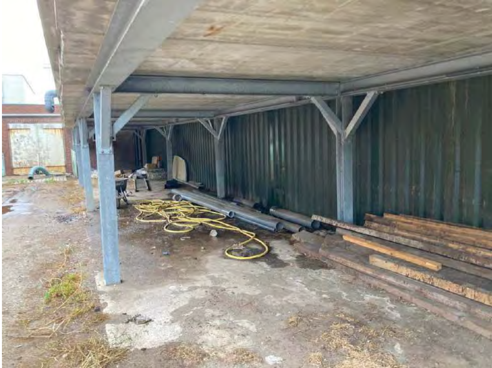
• Afbeelding 5: onderzijde luchtwassers
