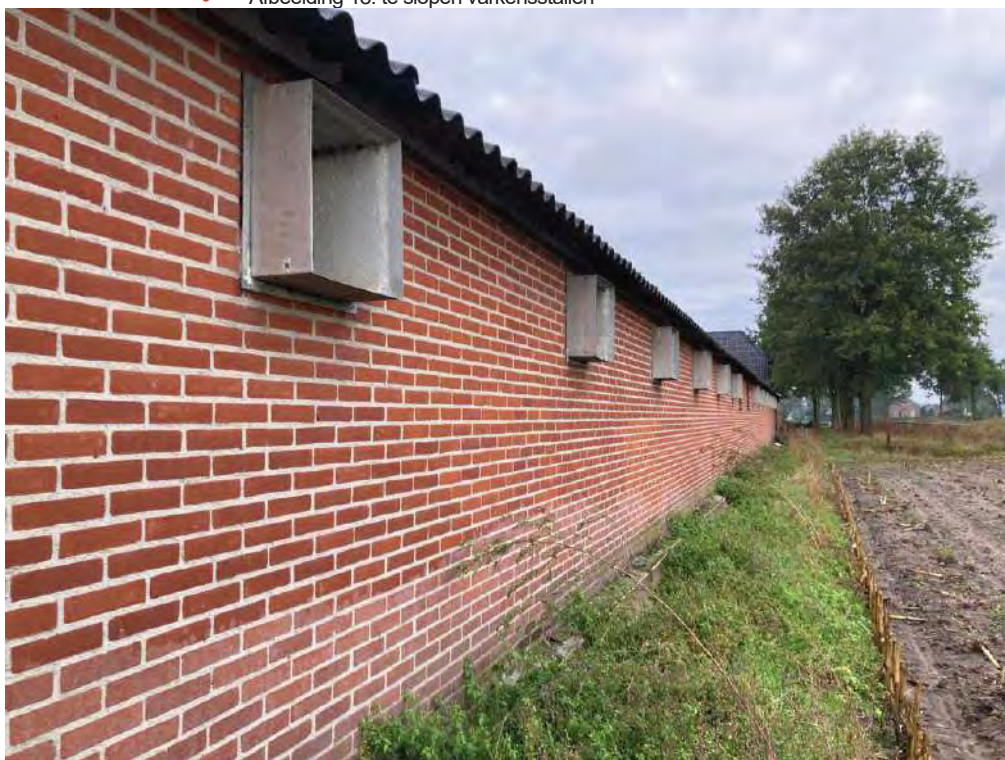
• Afbeelding 18: te slopen varkensstallen
