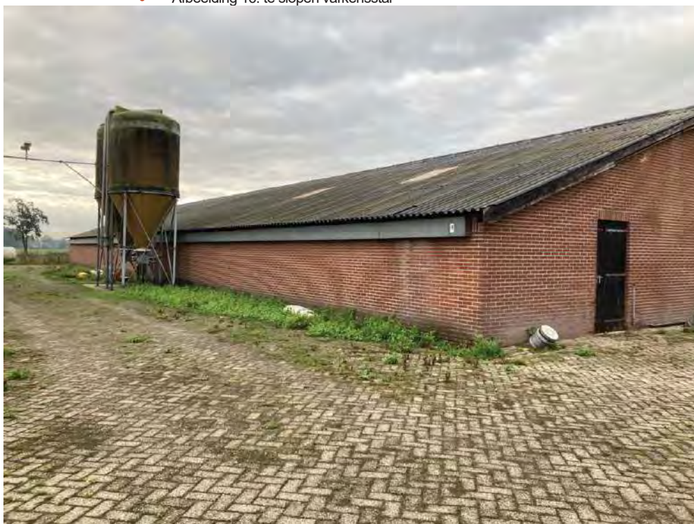
• Afbeelding 16: te slopen varkensstal
