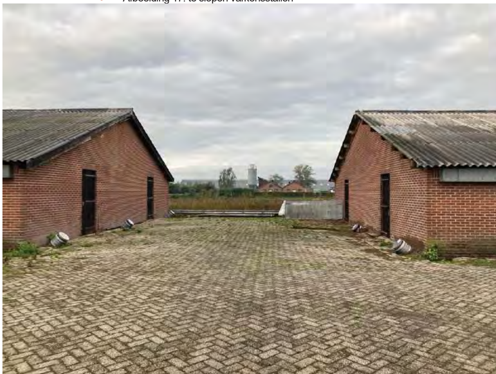
• Afbeelding 17: te slopen varkensstallen
