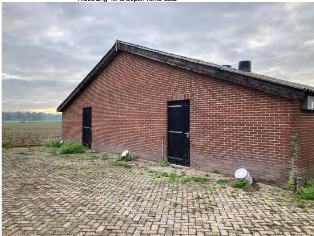
• Afbeelding 15: te slopen varkensstal
