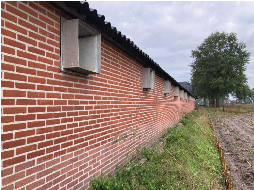
• Afbeelding 18: te slopen varkensstallen
