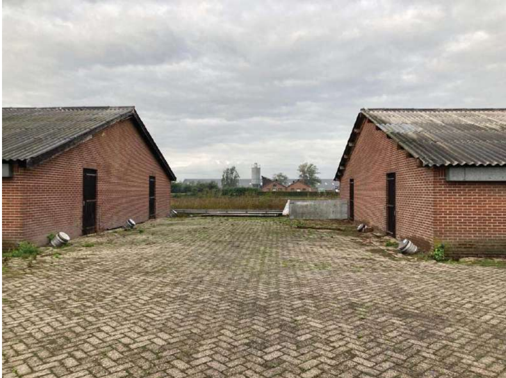
• Afbeelding 17: te slopen varkensstallen
