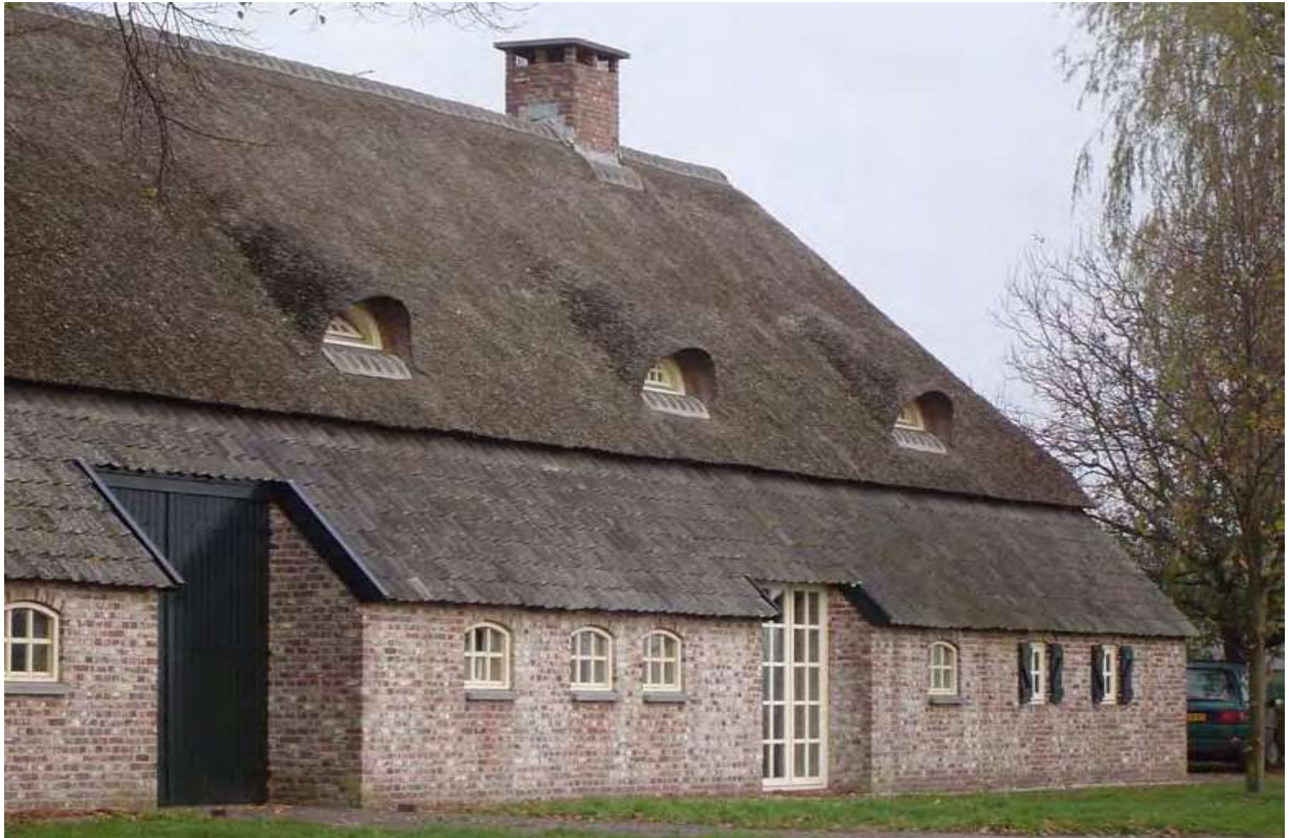
^ boerderij met rieten kap + dakkapellen + lage gootlijn
