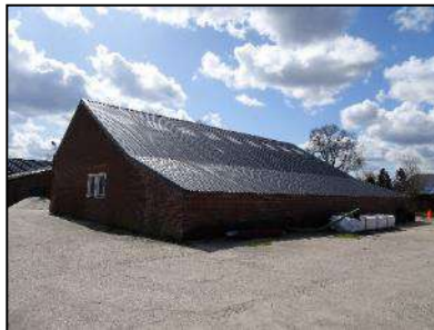
Figuur 4. Werkschuur op onderzoekslocatie (noordzijde).
