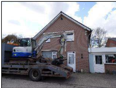
Figuur 3. Woonhuis op onderzoekslocatie.
