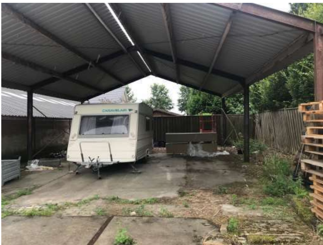
Foto 4: overdekte schuur met betonverharding
