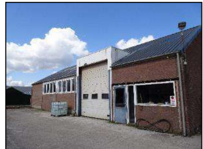
Figuur 5. Werkschuur op onderzoekslocatie (zuidzijde).
