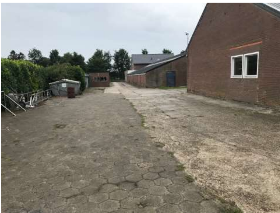
Foto 9: Achterzijde terrein voorzien van betonverharding en betontegels
