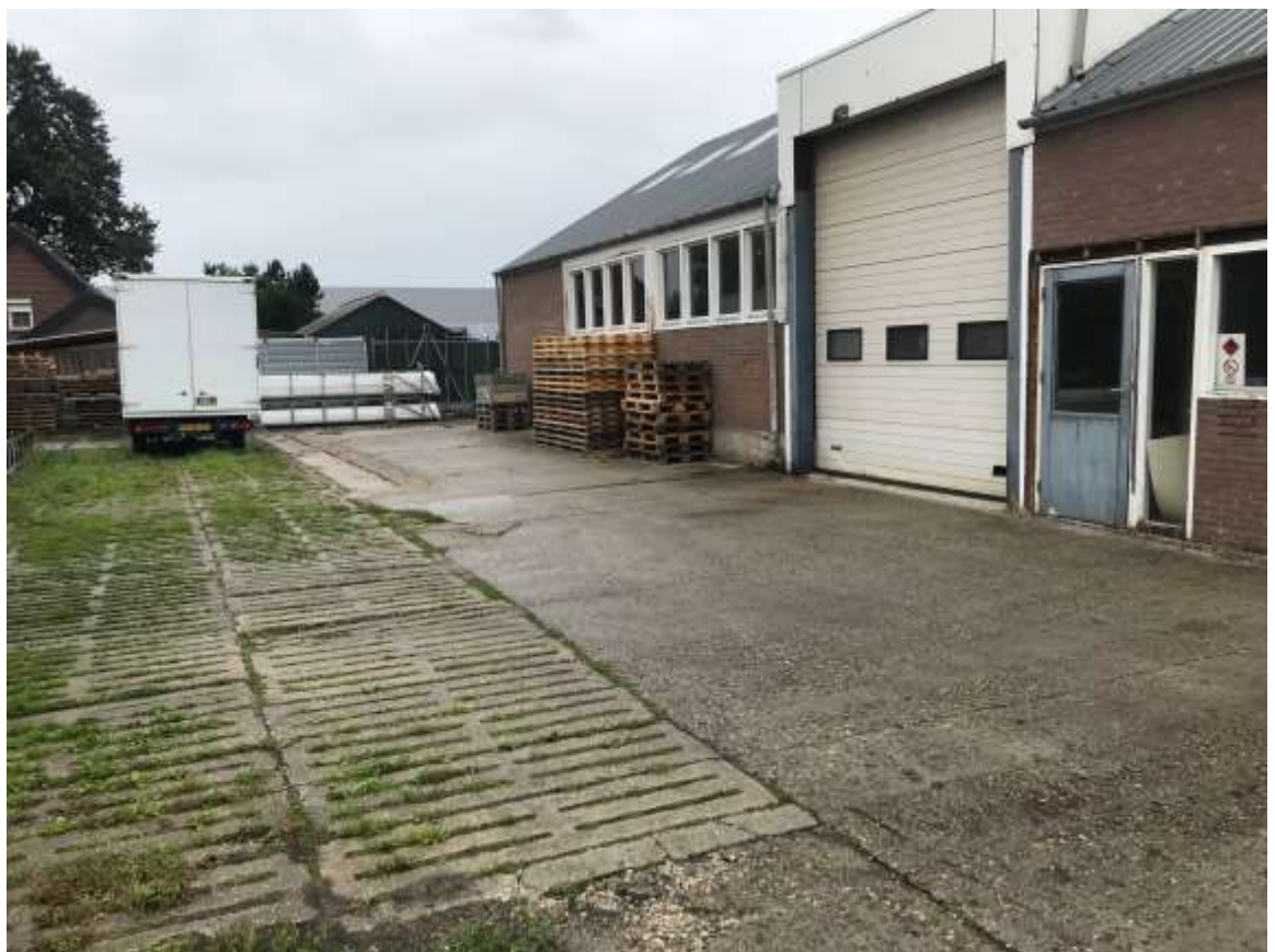
Afbeelding 2: Foto loods annex werkplaats met ligging betonverharding
