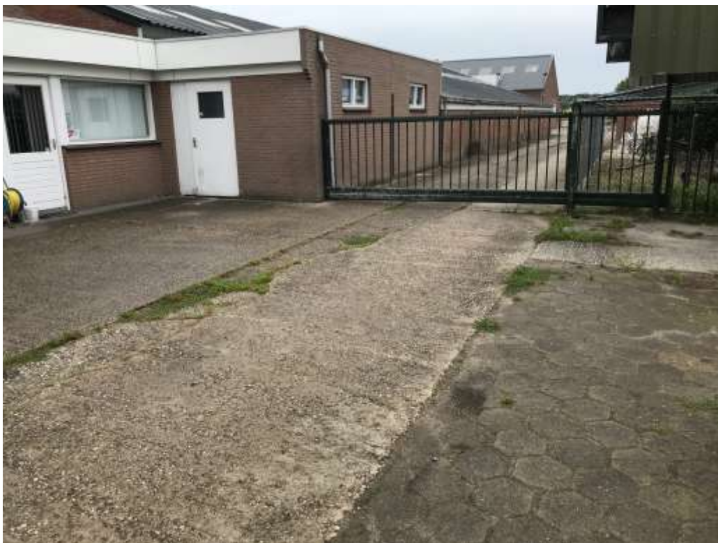
Foto 1: Toegangspoort met betonverharding en beton tegels
