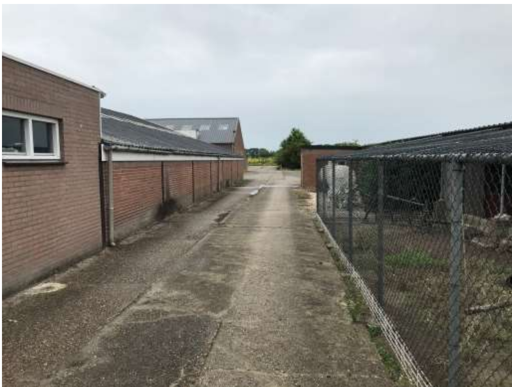
Foto 2: Erfpad (beton) tussen schuur en vogelren
