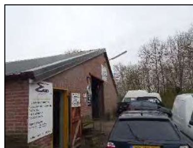
Figuur 5. Middelste pand op onderzoekslocatie; autobedrijf EMRO.
