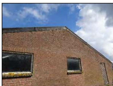
Figuur 6. Voorgevel voormalige varkensstal.
