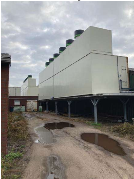
• Afbeelding 4: luchtwassers
