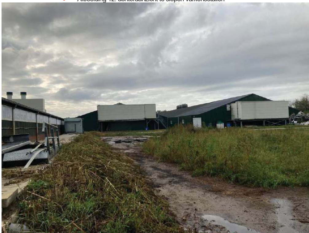
• Afbeelding 12: achteraanzicht te slopen varkensstallen
