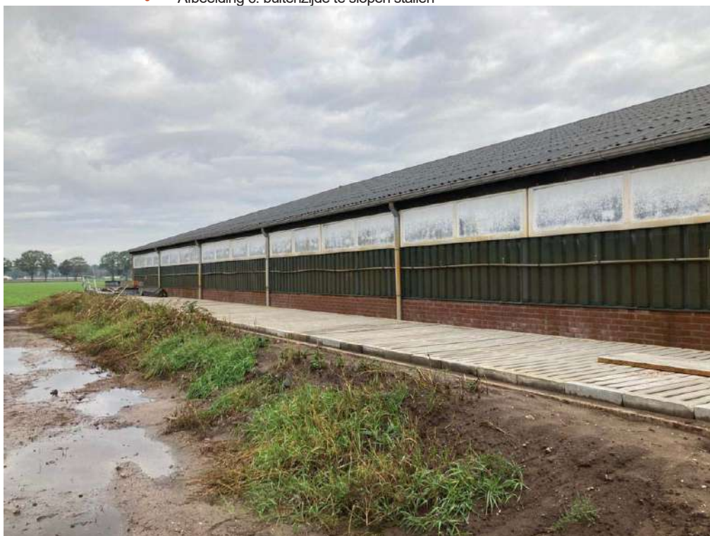
• Afbeelding 6: buitenzijde te slopen stallen
