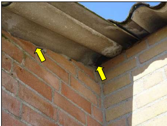
Figuur 11. Geschikte invliegmogelijkheden voor vleermuizen; open voegen en gaten onder het dak.
