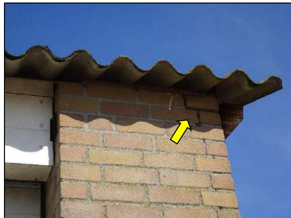
Figuur 12. Geschikte invliegmogelijkheden voor vleermuizen; open voegen.
