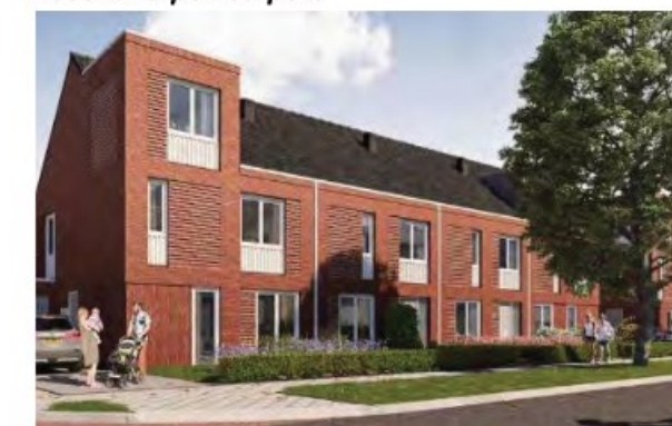
onderbreking goothoogte over maximaal 3m
