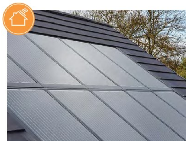
> Benut dakvlakken voor het plaatsen van zonnepanelen
