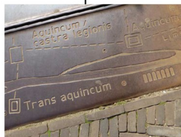
Lijnvormig element in verharding, d.m.v. natuurstenen of cortenstalen band
