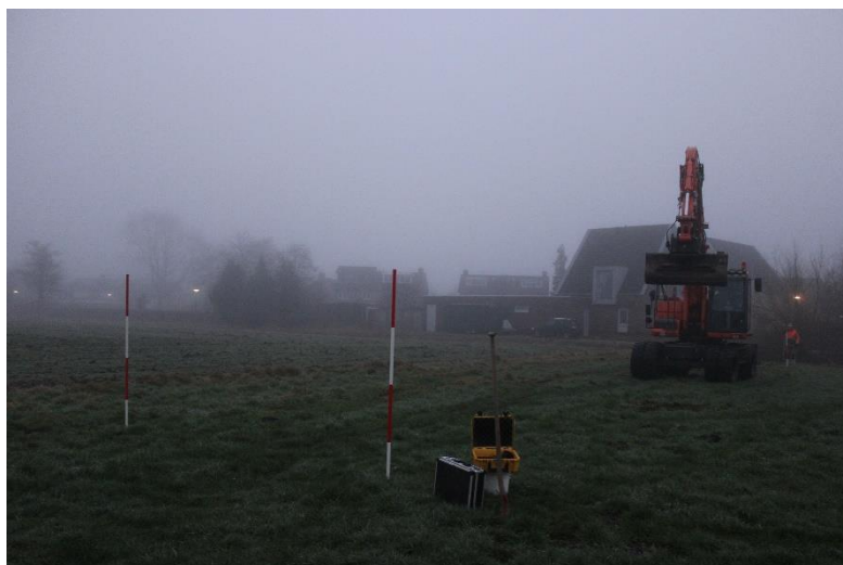
Fig. 1.2 Gemert-Deelvoort. De aanleg van werkput 1 en 2.
