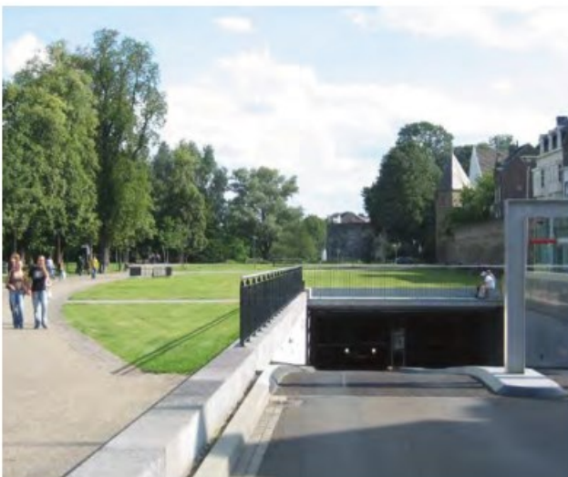
Afb. 67 – referentiebeeld: ondergronds parkeren, Maastricht
