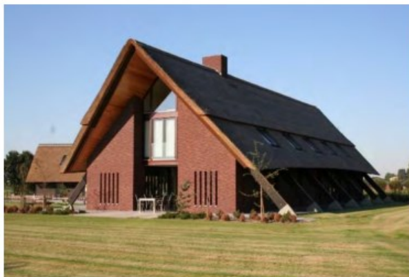
constructie en kap zijn dominant
