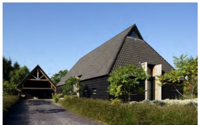
zadeldak met schild en smalle insneden
