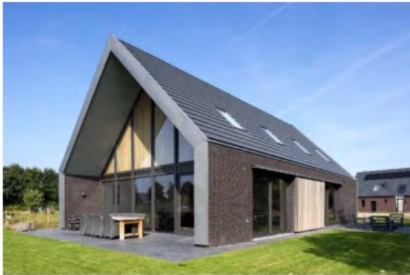
langsgevel en dak vormen een 'deken'
