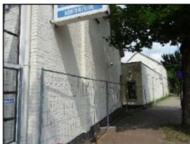
Figuur 4. Zuidkant bebouwing Binderseind 50 en 52.
