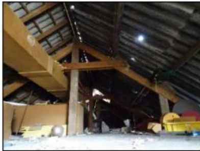
Figuur 22. Zolder 1 met dakraam en houten balken dakconstructie (Binders-eind 50 en 52).
