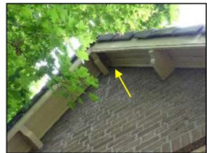
Figuur 18. Ruimte in dakrand geschikt als broedlocatie gierzwaluw (Churchillaan 10).
