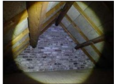
Figuur 24. Zolder 3 met dakbeschot en houten balken dakconstructie (Churchill-laan 10).
