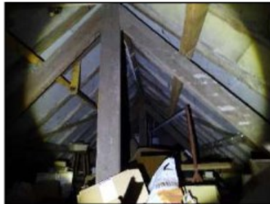
Figuur 23. Zolder 2 met dakbeschot en houten balken dakconstructie (Binders-eind 50 en 52).
