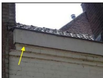
Figuur 20. Ruimte in dakrand geschikt als verblijfplaats voor vleermuizen (Binderseind 50 en 52).
