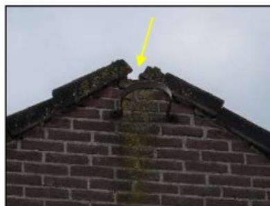
Figuur 14. Ruimte onder dakpannen geschikt als broedlocatie voor huismus (Binderseind 50 en 52).
