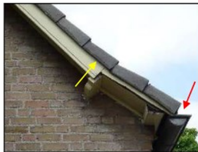
Figuur 17. Ruimte onder dakpannen en tussen overhangende dakpannen geschikt als broedlocatie huismus en gierzwaluw (Churchillaan 10).
