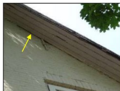
Figuur 21. Ruimte in dakrand geschikt als verblijfplaats voor vleermuizen (Binderseind 50 en 52).
