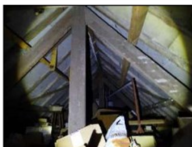
Figuur 23. Zolder 2 met dakbeschoot en houten balken dakconstructie (Binders-eind 50 en 52).
