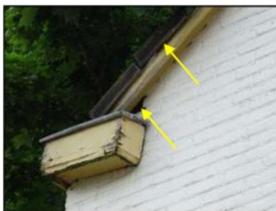
Figuur 13. Ruimte in gevel en tussen overhangende dakpannen geschikt als broedlocatie huismus en gierzwaluw (Binderseind 50 en 52).
