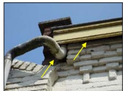
Figuur 15. Ruimte achter regenpijp of dakrand geschikt als broedlocatie gierzwaluw (Binderseind 50 en 52).
