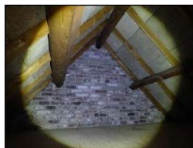
Figuur 24. Zolder 3 met dakbeschoot en houten balken dakconstructie (Churchill-laan 10).
