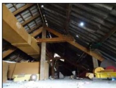
Figuur 22. Zolder 1 met dakraam en houten balken dakconstructie (Binders-eind 50 en 52).
