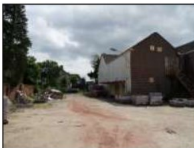
Figuur 6. Oostzijde naast bebouwing Binderseind 50 en 52.
