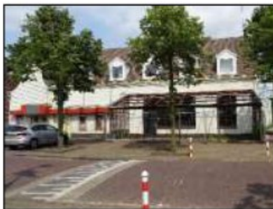
Figuur 3. Vooraanzicht bebouwing Binderseind 50 en 52.
