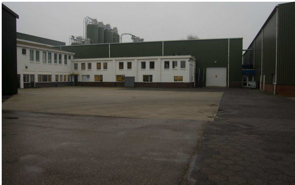
Figuur 9. Schone, verharde oppervlakken rond de fabrieksgebouwen.
