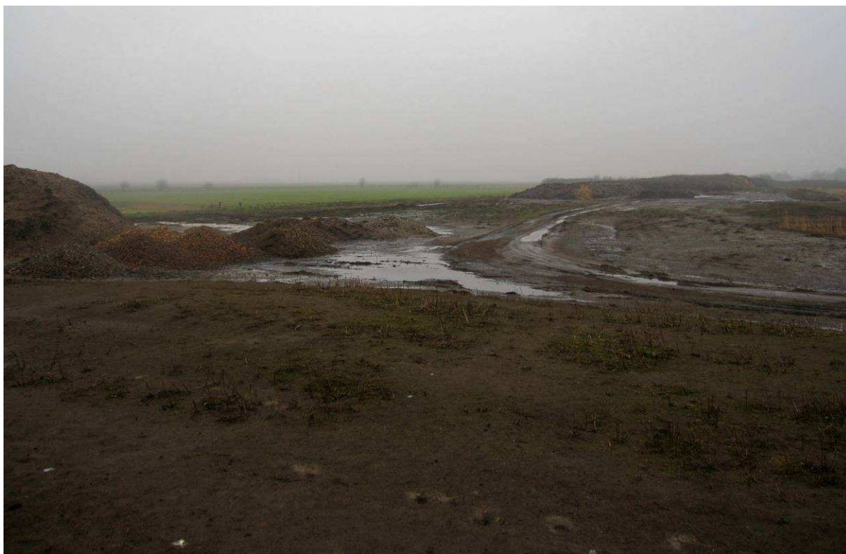
Figuur 16. Locatie vergistingsinstallatie vanuit het westen.
