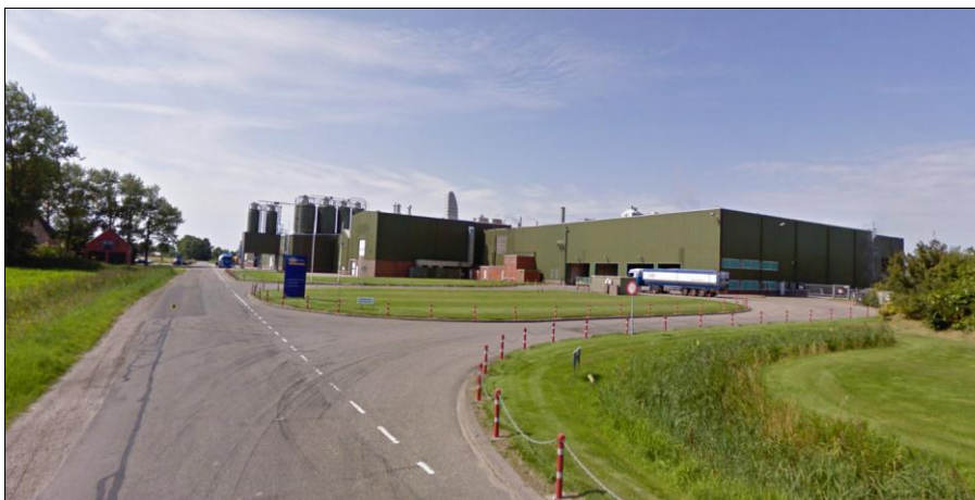
Zicht vanuit het oosten op Aviko/Rixona
