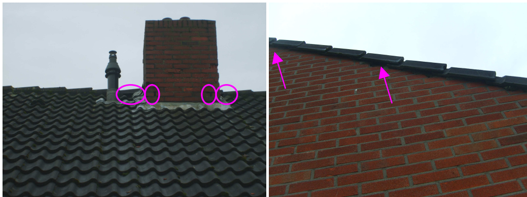
Figuur 4: Mogelijkheden in de te slopen woningblokken waar vleermuizen gebruik van kunnen maken.
