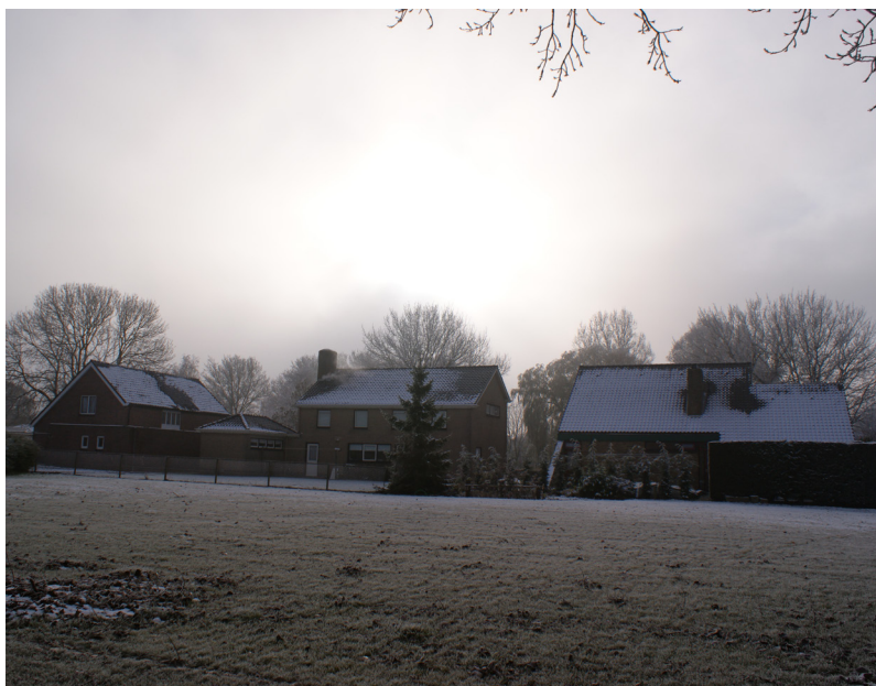
bestaande bebouwing aan de Lijnbaan
