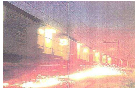
Figuur: Het bijslijpen van spoorstaven.
