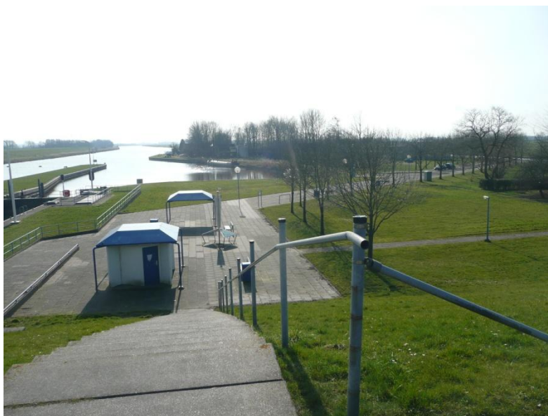
Foto 3.2 Overzicht TOP Nieuw Statenzijl gezien in zuidelijke richting
