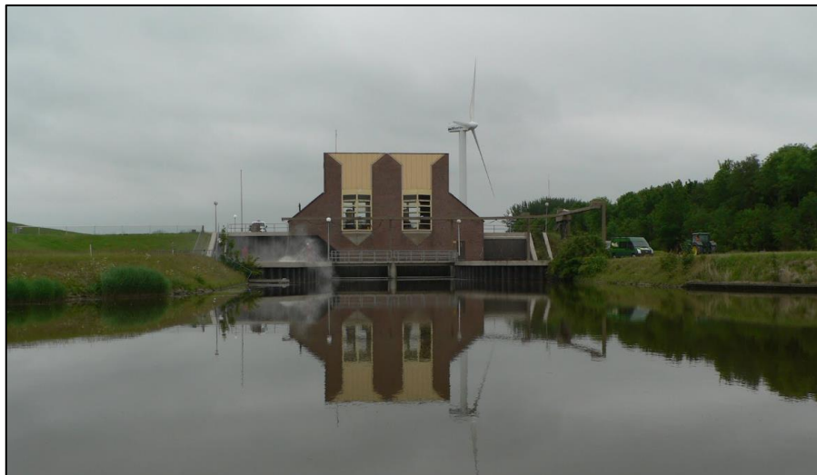
Afbeelding 4. Gemaal Spijksterpompen en windturbine (Street View).
