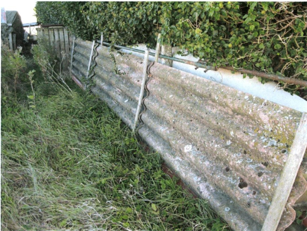
Foto 77; Asbestverdachte erfafscheiding, noordzijde Oostpolder 6, in oostelijke richting
