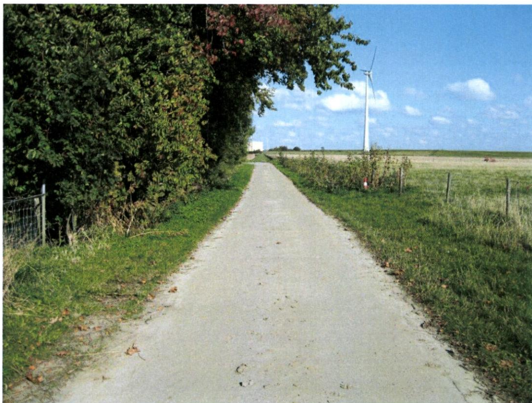
Foto 70; betonnen toegangsweg nabij Oostpolder 7, in noordoostelijke richting
