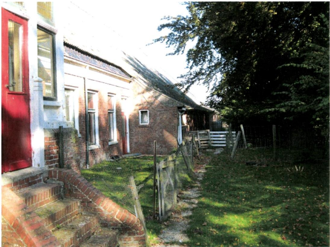
Foto 56; zuidoostgevel Oostpolder 7; in noordoostelijke richting
