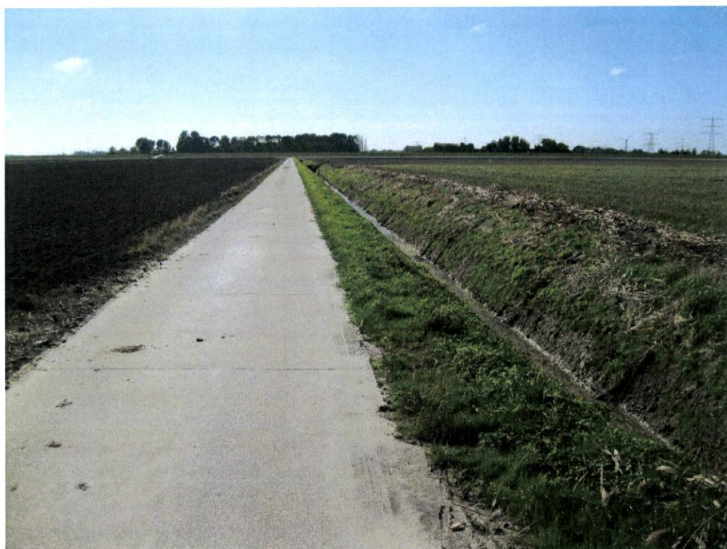
Foto 69; betonnen toegangsweg nabij Oostpolder 7 in zuidwestelijke richting
