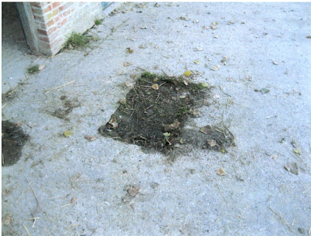
Foto 47; tegel in beton t.p.v. locatie ondergrondse tank Noordzijde Oostpolder 7
