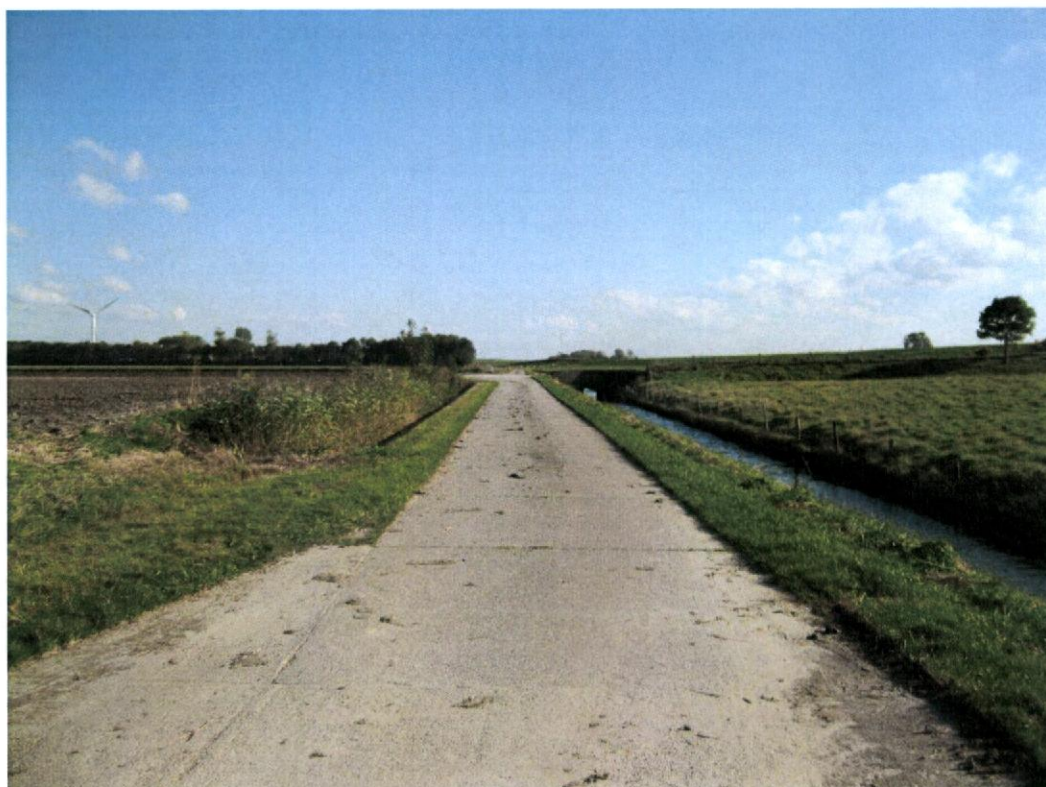
Foto 94; betonweg langs zuidgrens onderzoeksgebied in zuidoostelijke richting
