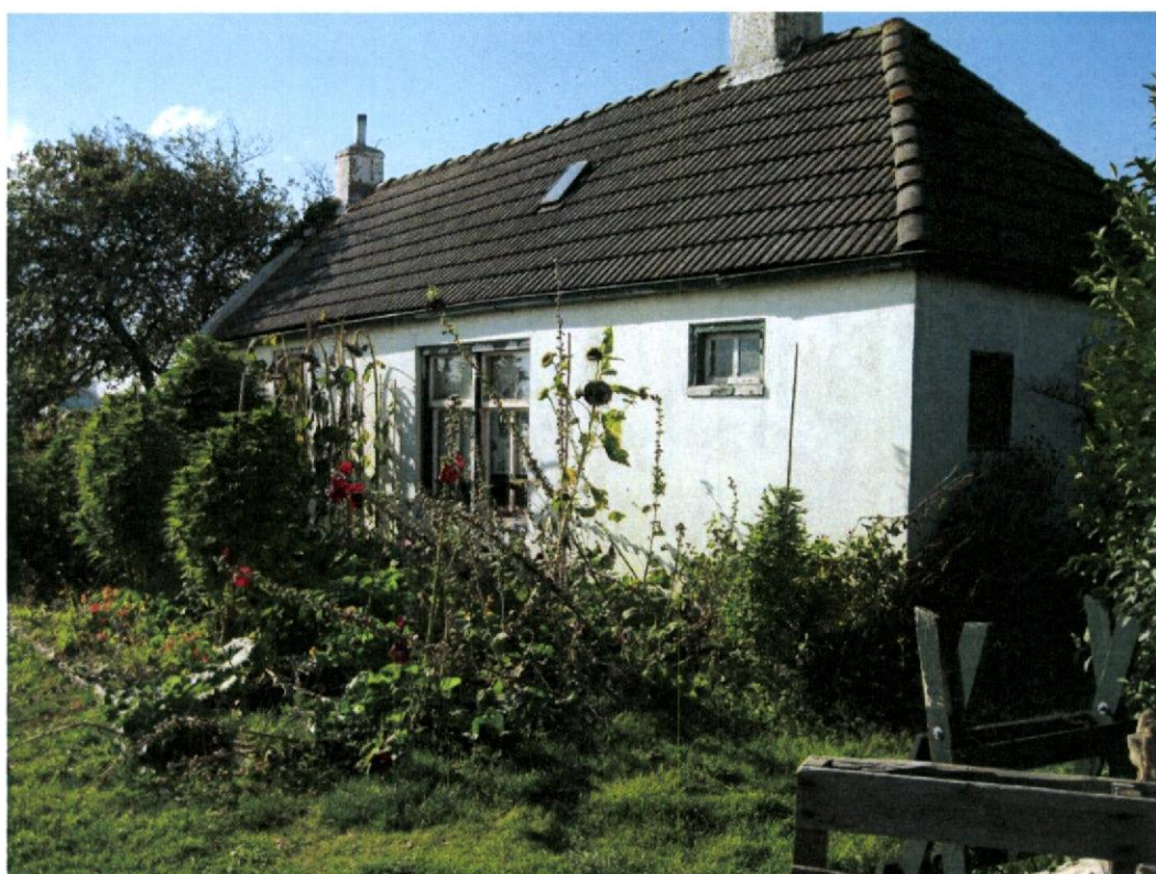
Foto 86; Oostpolderweg 6 (locatie E) in zuidwestelijke richting
