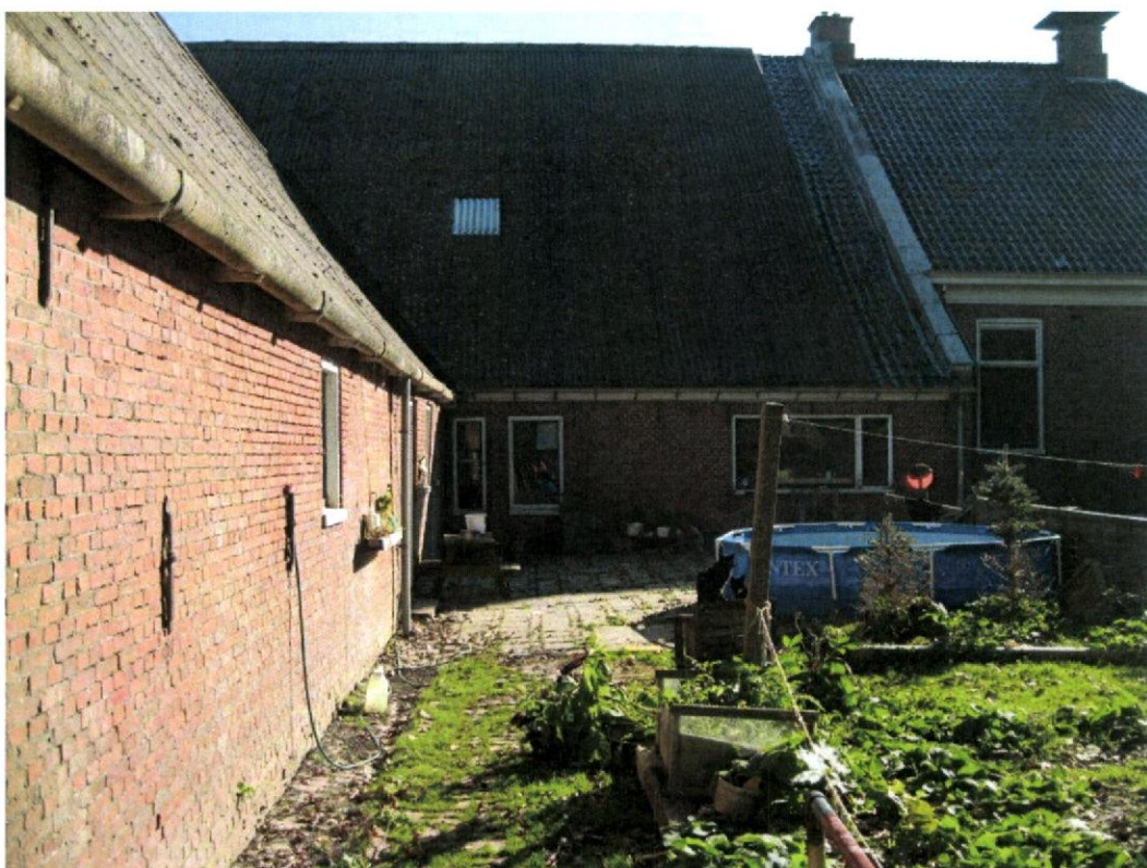
Foto 53; woongedeelte Oostpolder 7, in zuidoostelijke richting
