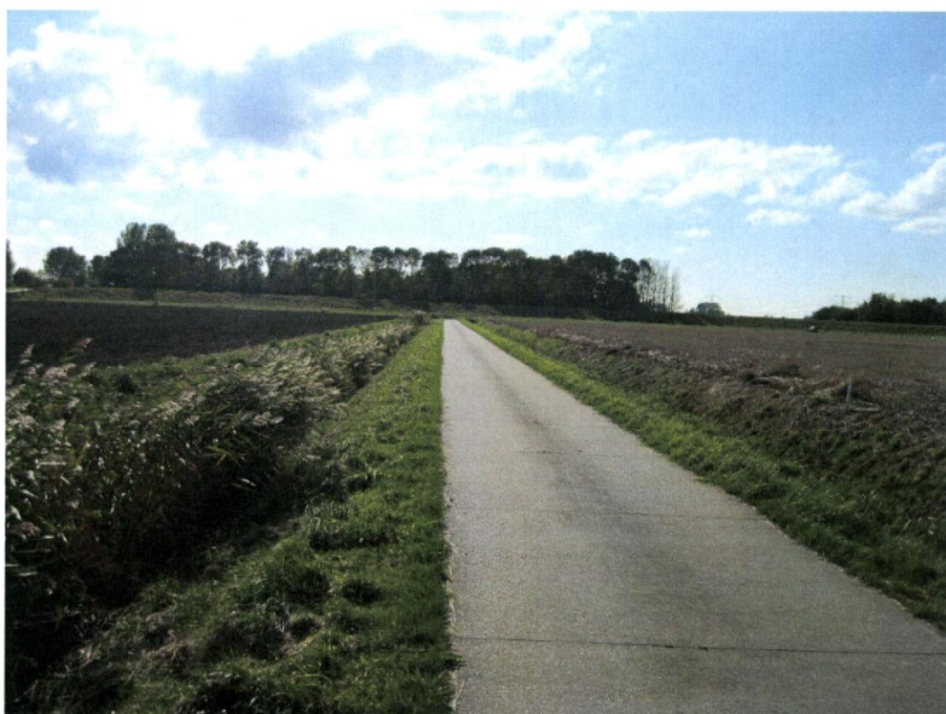
Foto 92; betonnen toegangsweg ten zuidwesten van Oostpolder 7, in zuidwestelijke richting
