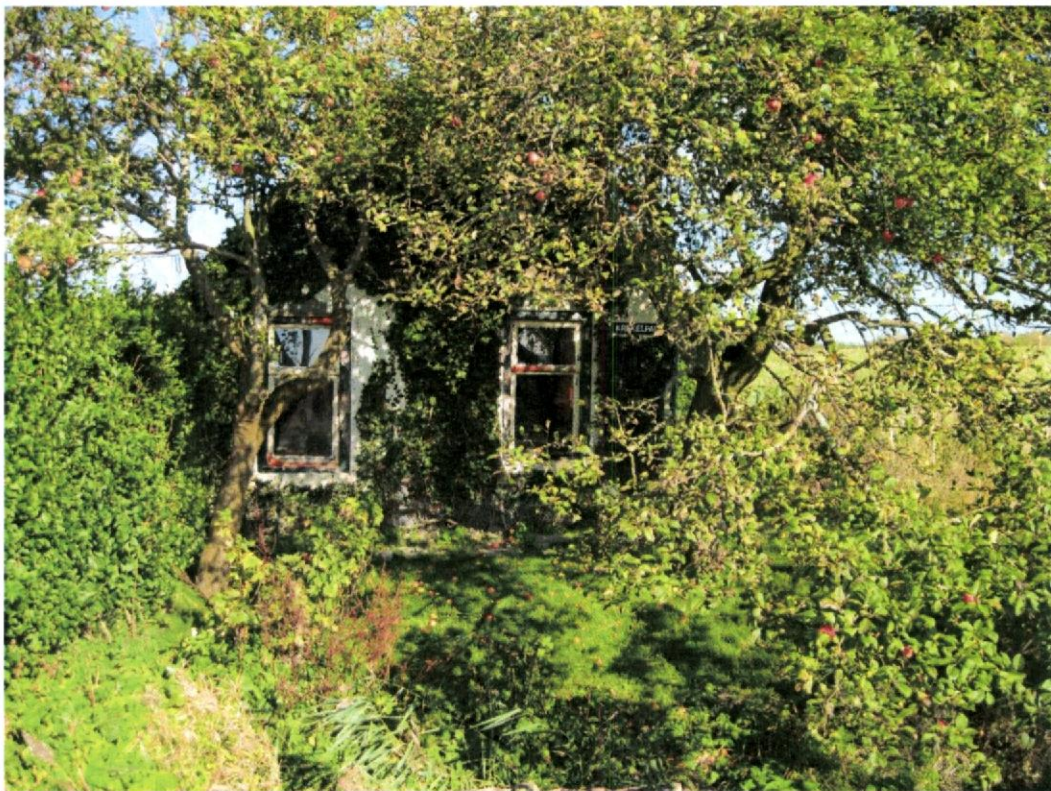
Foto 80; Aanzicht voorgevel Oostpolder 6 in noordoostelijke richting
