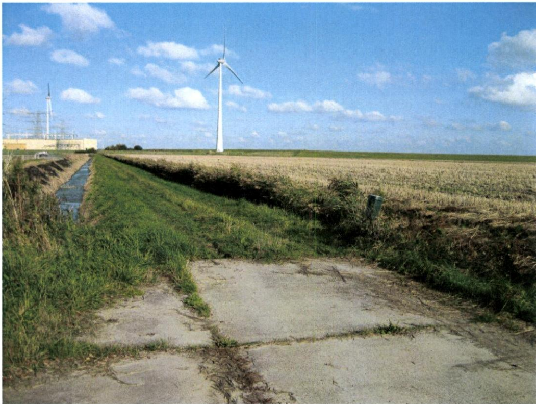
Foto 91; toegangsweg naar Oostpolder 6 (locatie E) in noordoostelijke richting
