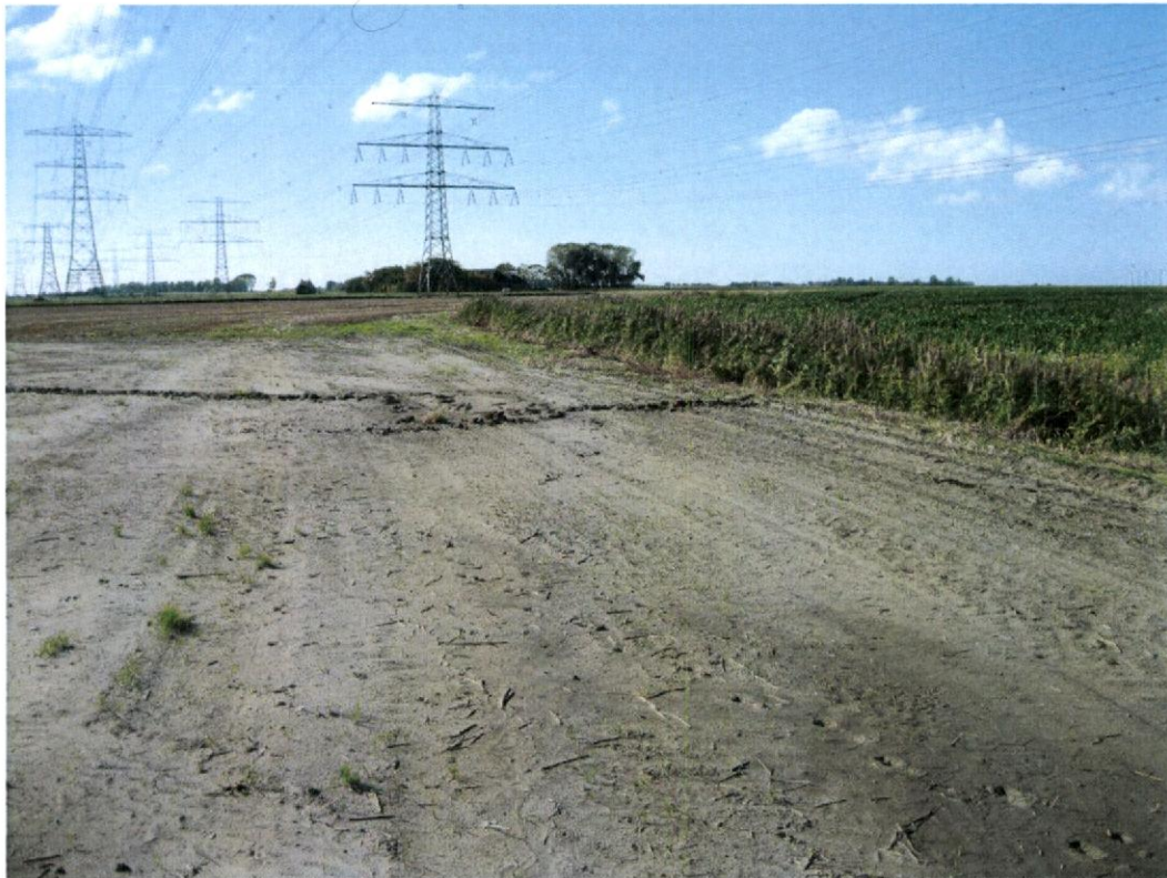
Foto 71; aanzicht huidige situatie locatie D, in westelijke richting
