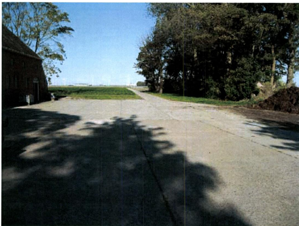
Foto 10; betonverharding achterzijde locatie G, in noordwestelijke richting
