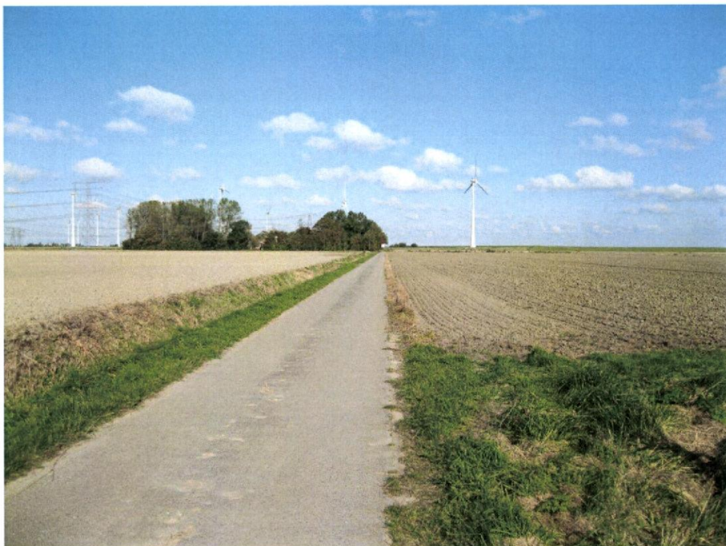
Foto 93; betonnen toegangsweg ten zuidwesten van Oostpolder 7, in noordoostelijke richting
