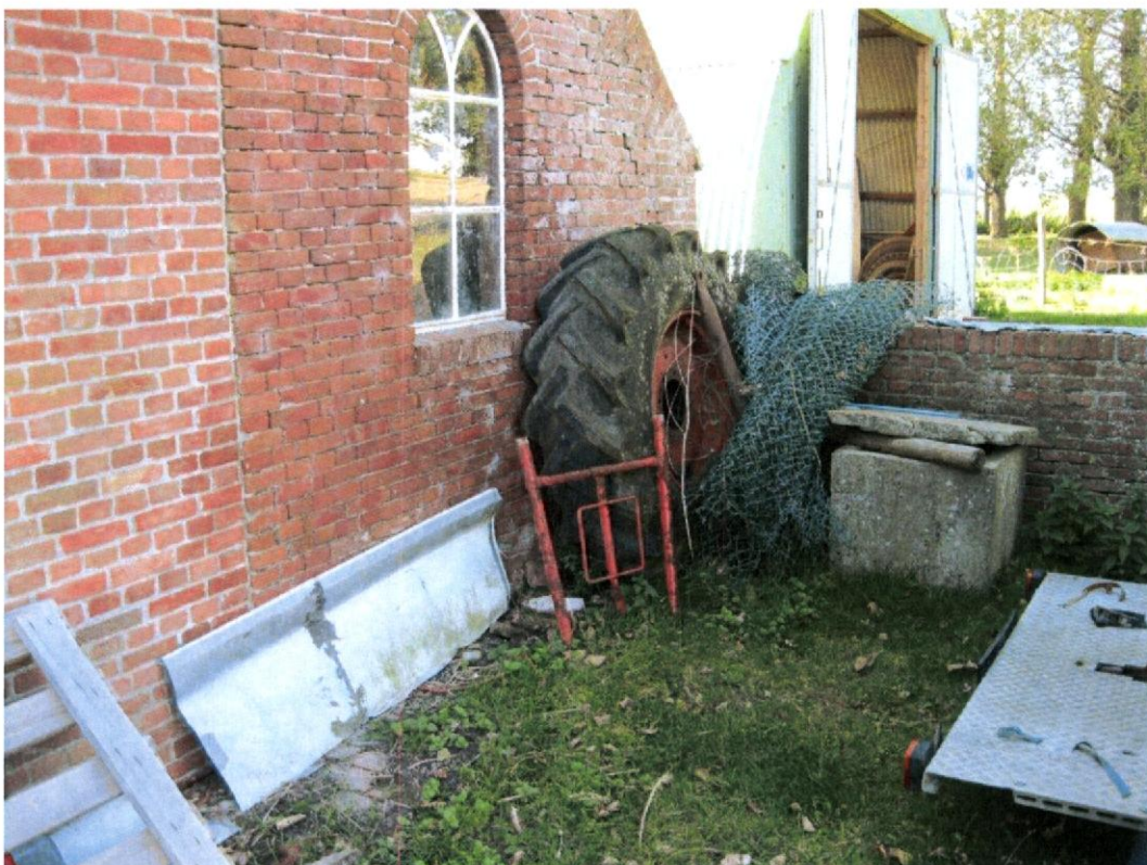
Foto 89; voormalige locatie bovengrondse tank, noordwesthoek Oostpolder 7
