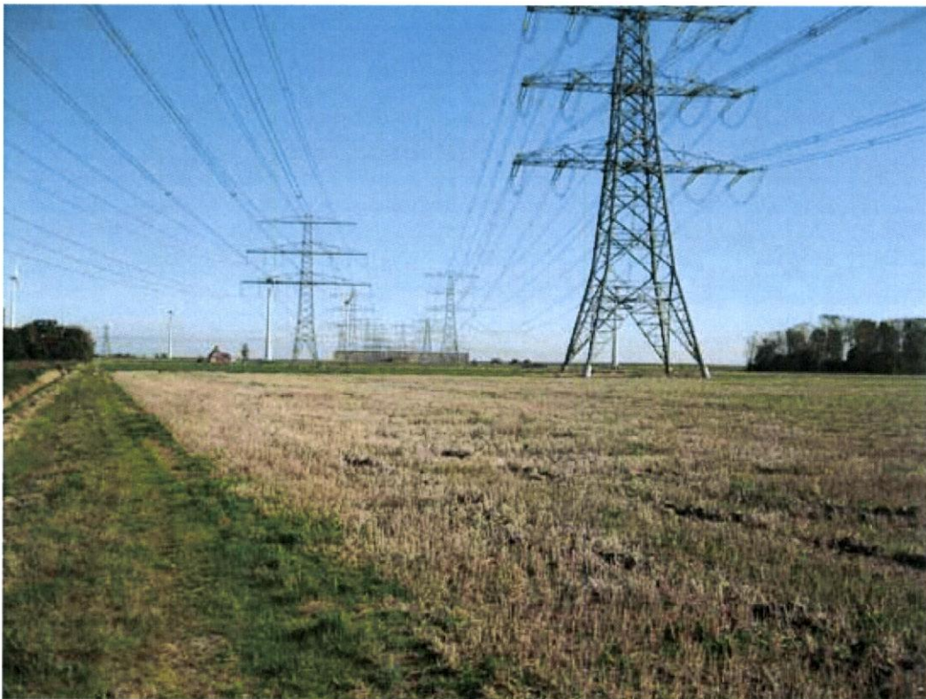
Foto 39; zuidoostelijk deel terrein, met pand Oostpolder 2, in noordoostelijke richting
