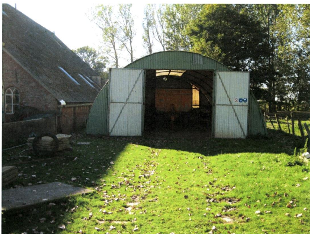
Foto 50; romneyloods ten westen van de schuren, Oostpolder 7, in zuidelijke richting
