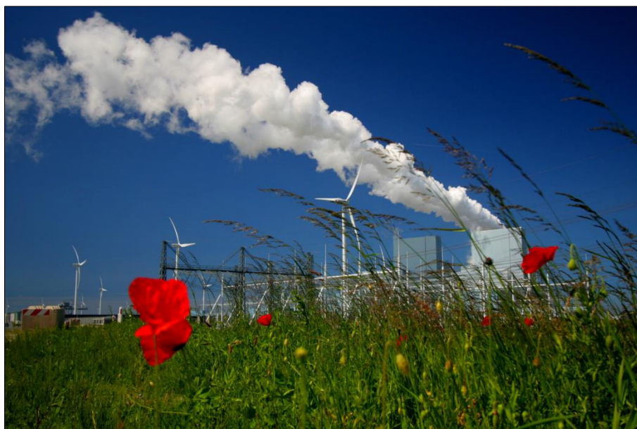
RWE centrale ten noorden van het plangebied
