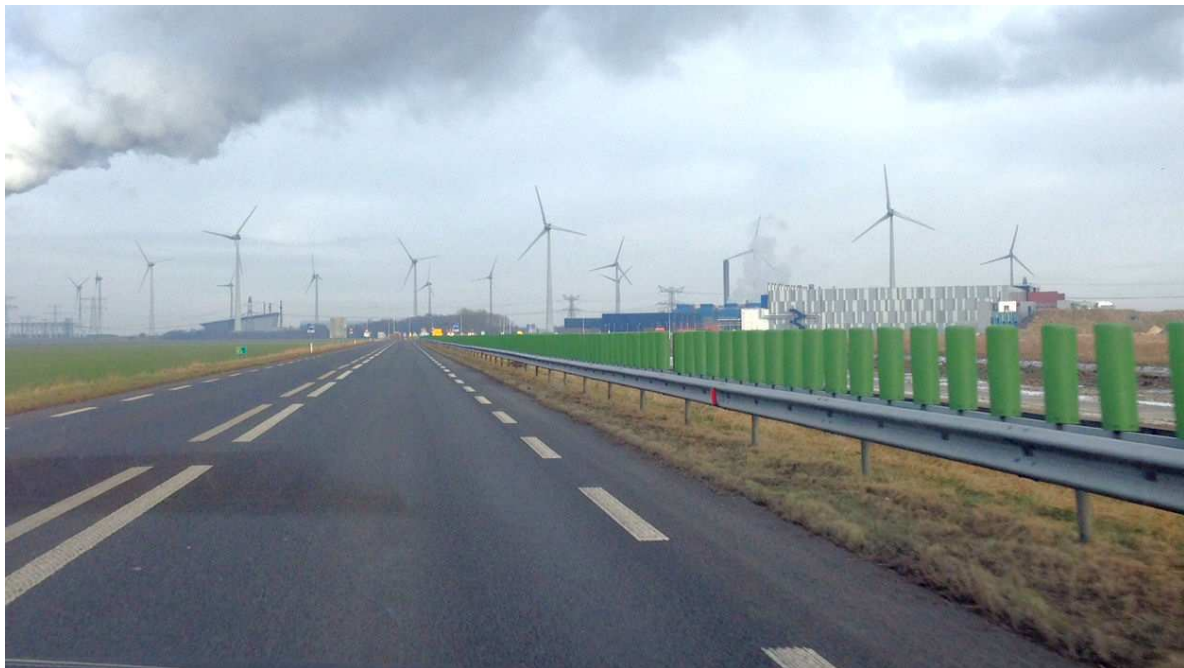
Afb. 7.1: Onderhavige wegvak N33, huidige situatie. Foto: auteurs.
