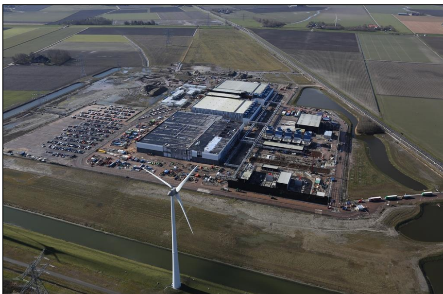
Afbeelding 6. Zuidoost fase 1 in aanleg (Bron: GSP)
