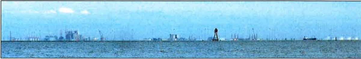
Abb.: Blick von Borkum auf den Eemshaven. Im Vordergrund der Leitdamm mit Leuchtturm von Borkum Reede.
