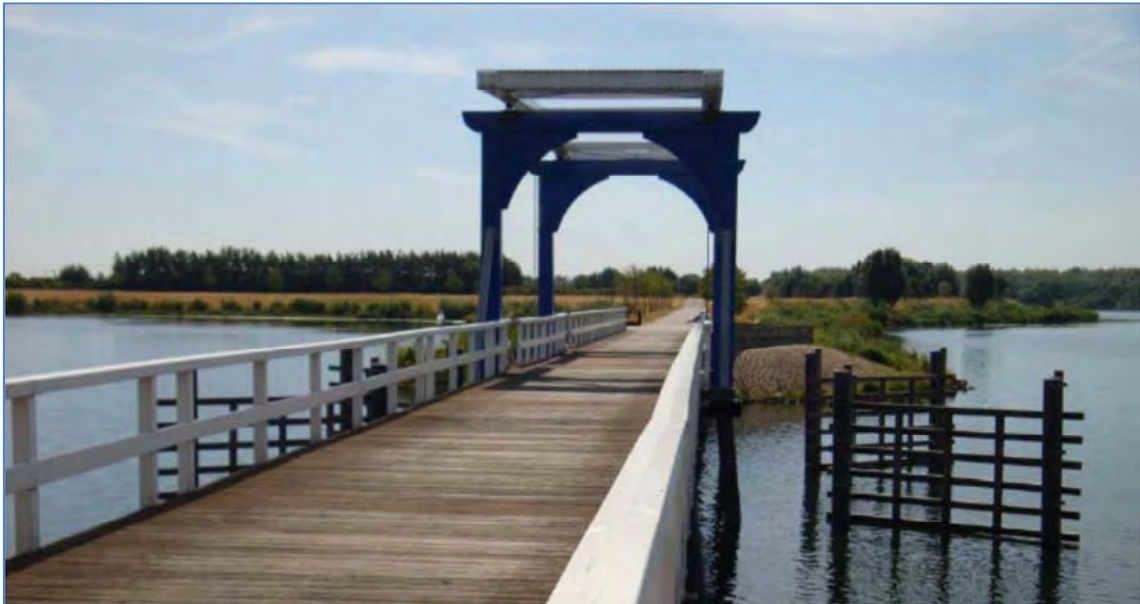
Afbeelding 47 Hefbrug grote Hegge Groeskamp (foto: P. Vossen)
