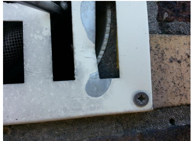
Fotonummer: FB04 Ventilatiekanalen en muurdoorvoeren zijn niet asbestverdacht.
