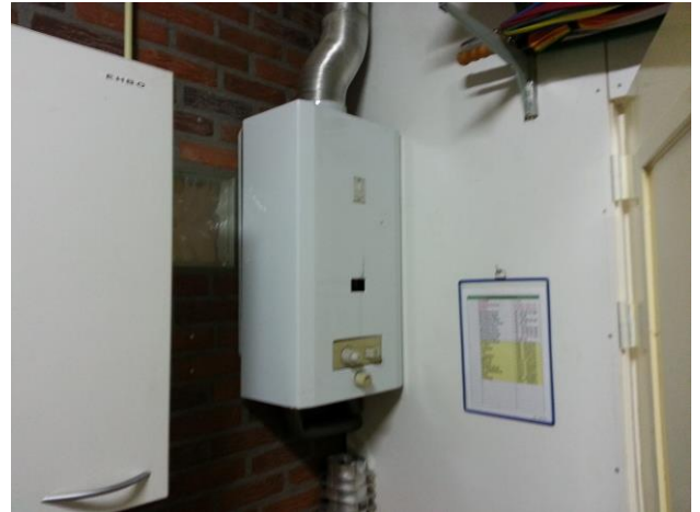
Fotonummer: FB02 De geiser in de berging is niet asbestverdacht.
