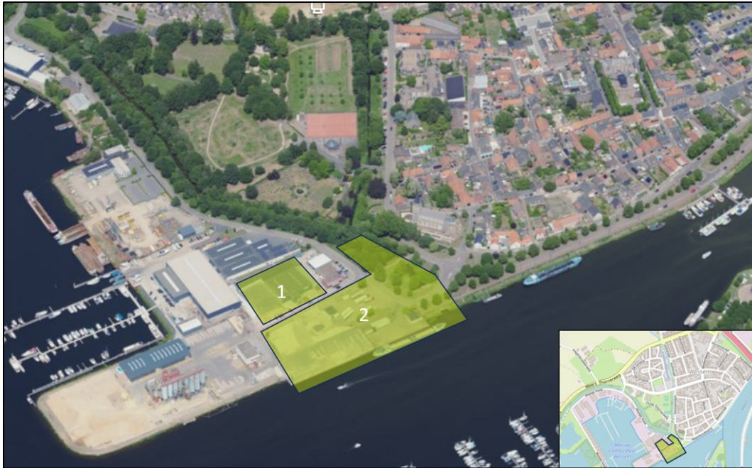
Figuur 2: Luchtfoto ligging Nautische Boulevard, Wessem, gemeente Maasgouw
