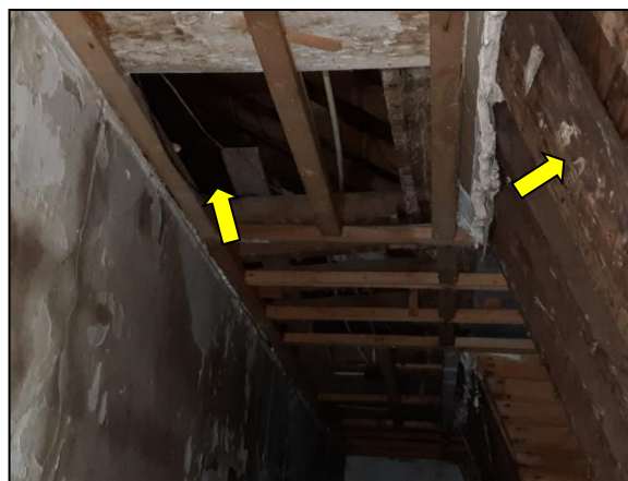
Figuur 26. Zolderruimte direct onder dak en ruimtes tussen dak beschot.
