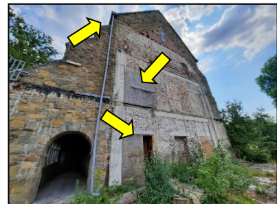
Figuur 24. Verschillende openingen die toegang verlenen tot kapel.
