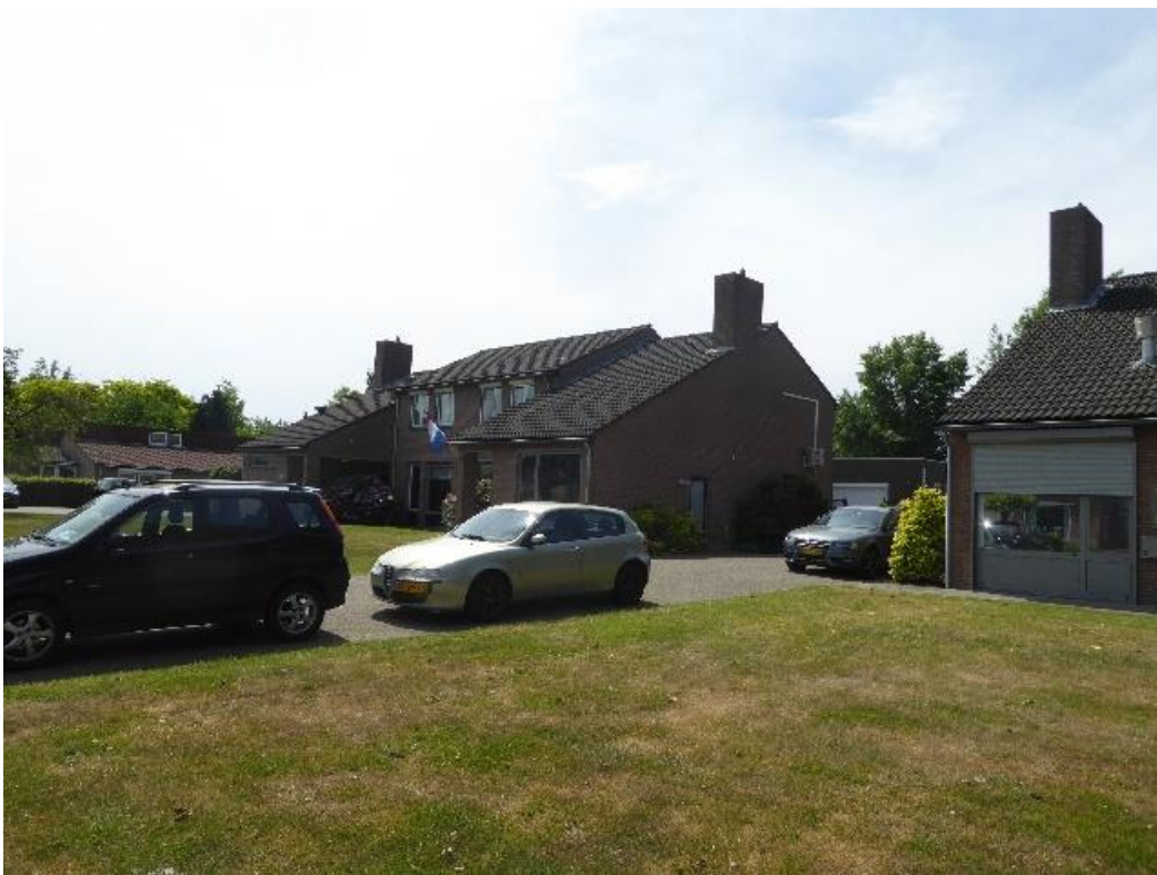
Afbeelding 8. Impressie bestaande bebouwing deelgebied 3.
