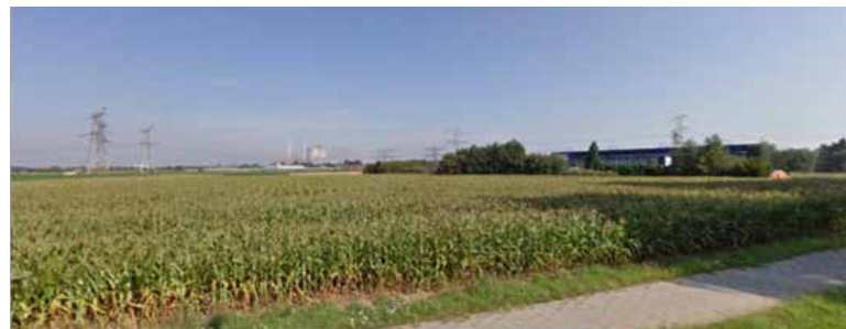
Het beeld vanaf de Rijksweg: De bedrijfsbebouwing met daarachter de energiecentrale en hoogspanningsmasten.
