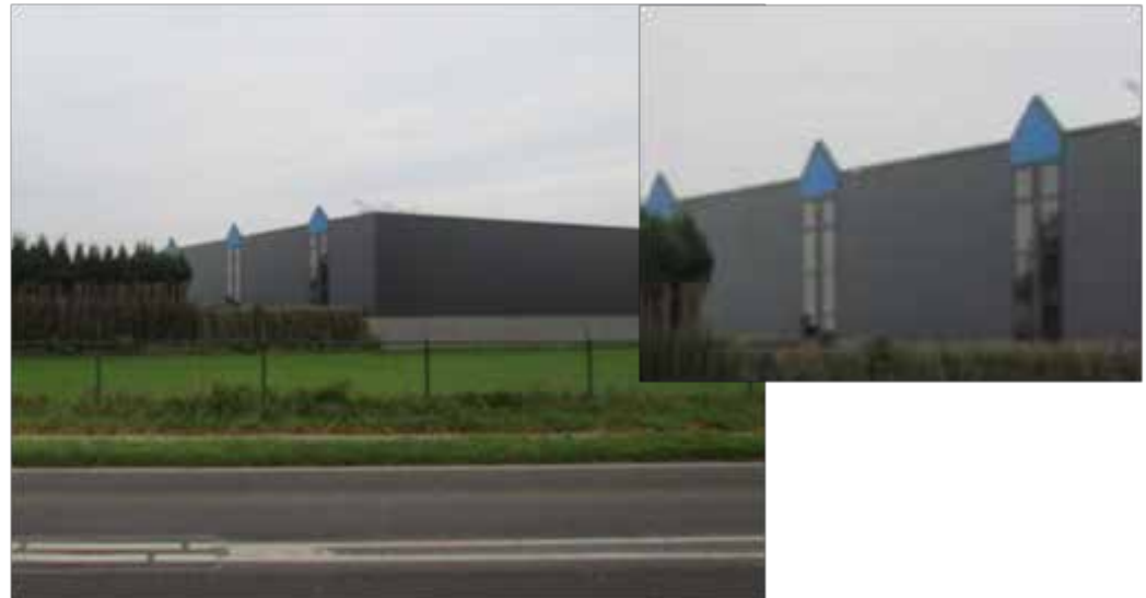
Zuid- en oostgevel recent gebouwde bedrijfsloods (2009).
