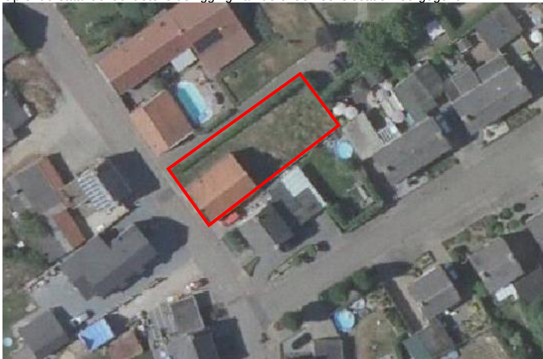
Afbeelding 1: luchtfoto van de onderzoekslocatie [bron: PDOKViewer]
