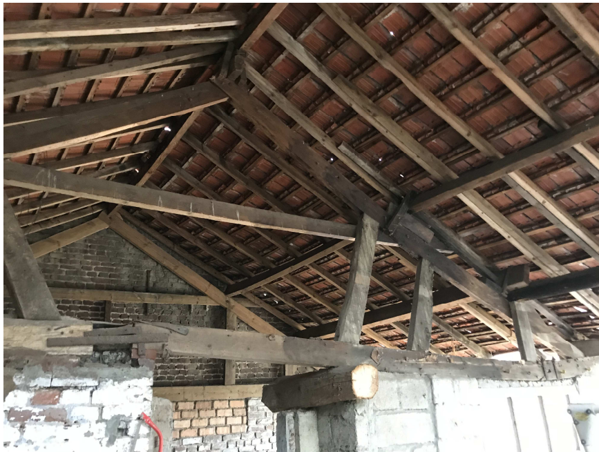
Figuur 7, foto dakconstructie kleine schuur
