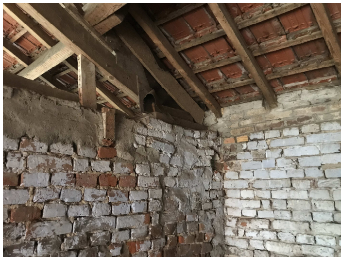
Figuur 8, foto close-up muur en dakconstructie kleine schuur
