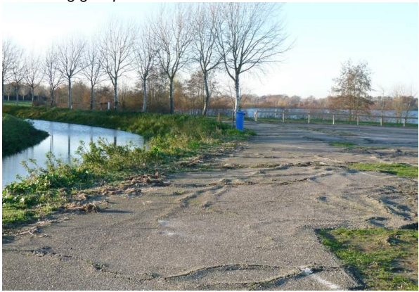
Figuur 7. Deel van de parkeerplaats, waar wortels van bomen het asfalt omhoog hebben gewerkt
