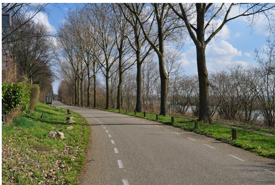
Figuur 4: Kadevak 50.630.15. Het wegtracé met laanbomen is zichtbaar. Uiterst rechts een ruiger bosschage dat de dijkflank begroeit.
