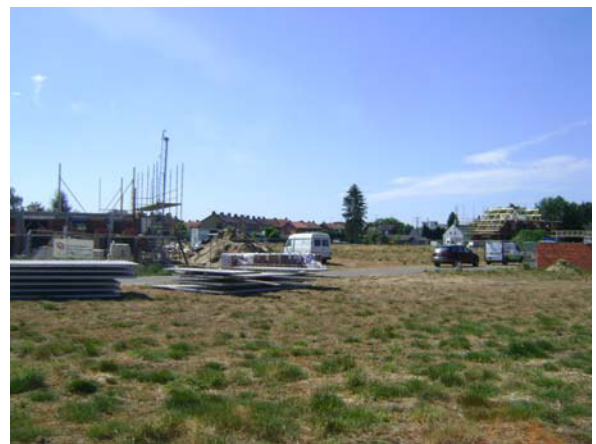
Foto 4: Zicht op de onderzoekslocatie en woningen in aanbouw.
