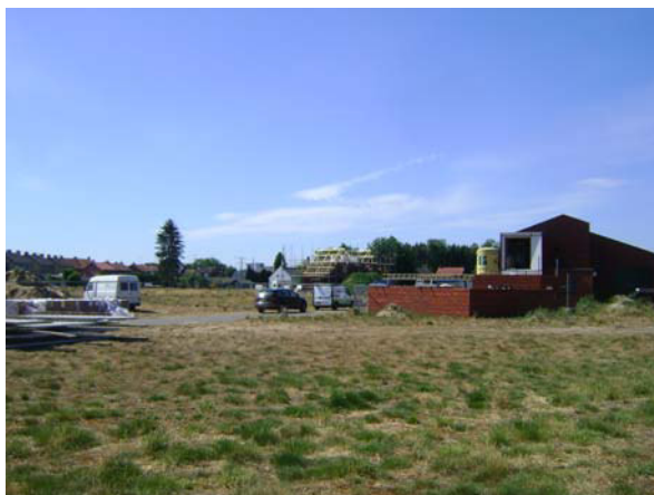
Foto 3: Zicht op de onderzoekslocatie en woningen in aanbouw.
