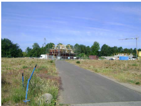
Foto 5: Bestaande asfaltweg binnen de onderzoekslocatie.
