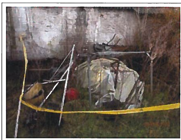
Foto 8: Puin naast het afgezet gebied uitgesloten van inspectie
