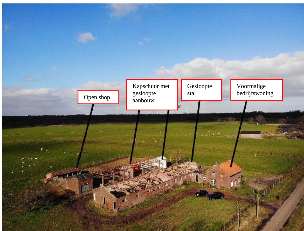
Figuur 2: Bestaande en voormalige ligging gebouwen op perceel met aangegeven de reeds gesloopte gebouwen
